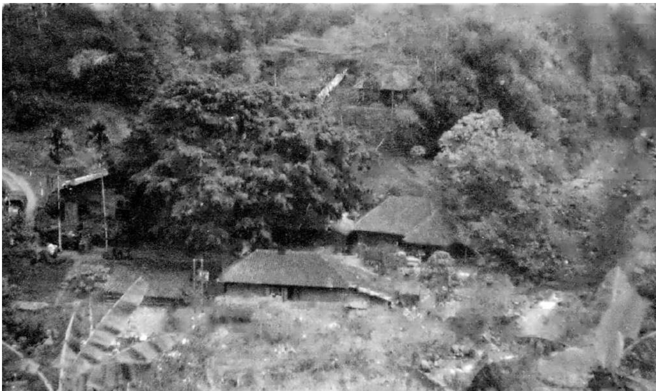
Tjoegenang - Gezicht op de electriciteits-centrale, boven-midden de aanvoerpijpen voor de turbine. (Nog geen brug)
