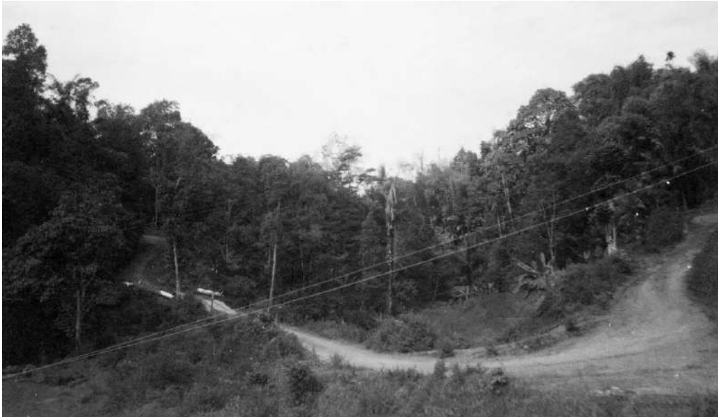
Tjoegenang - De weg naar de Centrale
